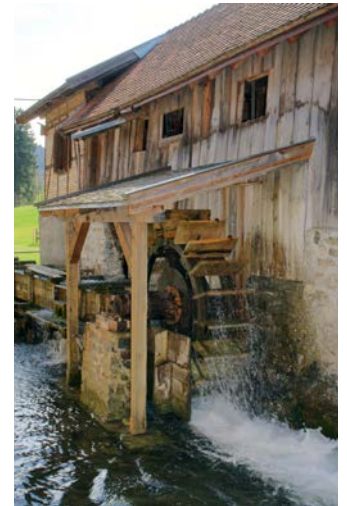
Läuft rund bei der alten Obermühle Säge
